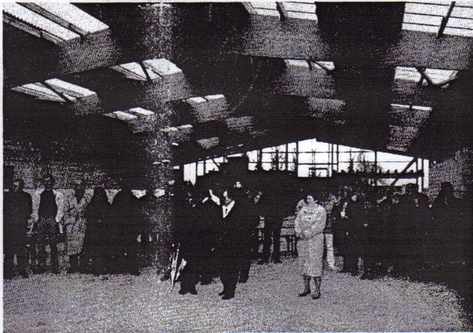
40 mal 60 Meter mißt die neue Halle am Ostburger Weg, die im Sommer fertiggestellt sein soll.
